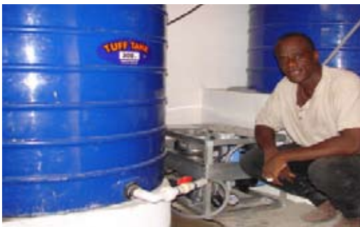
Wasseraufbereitungsanlage in Cap-Haïtien
